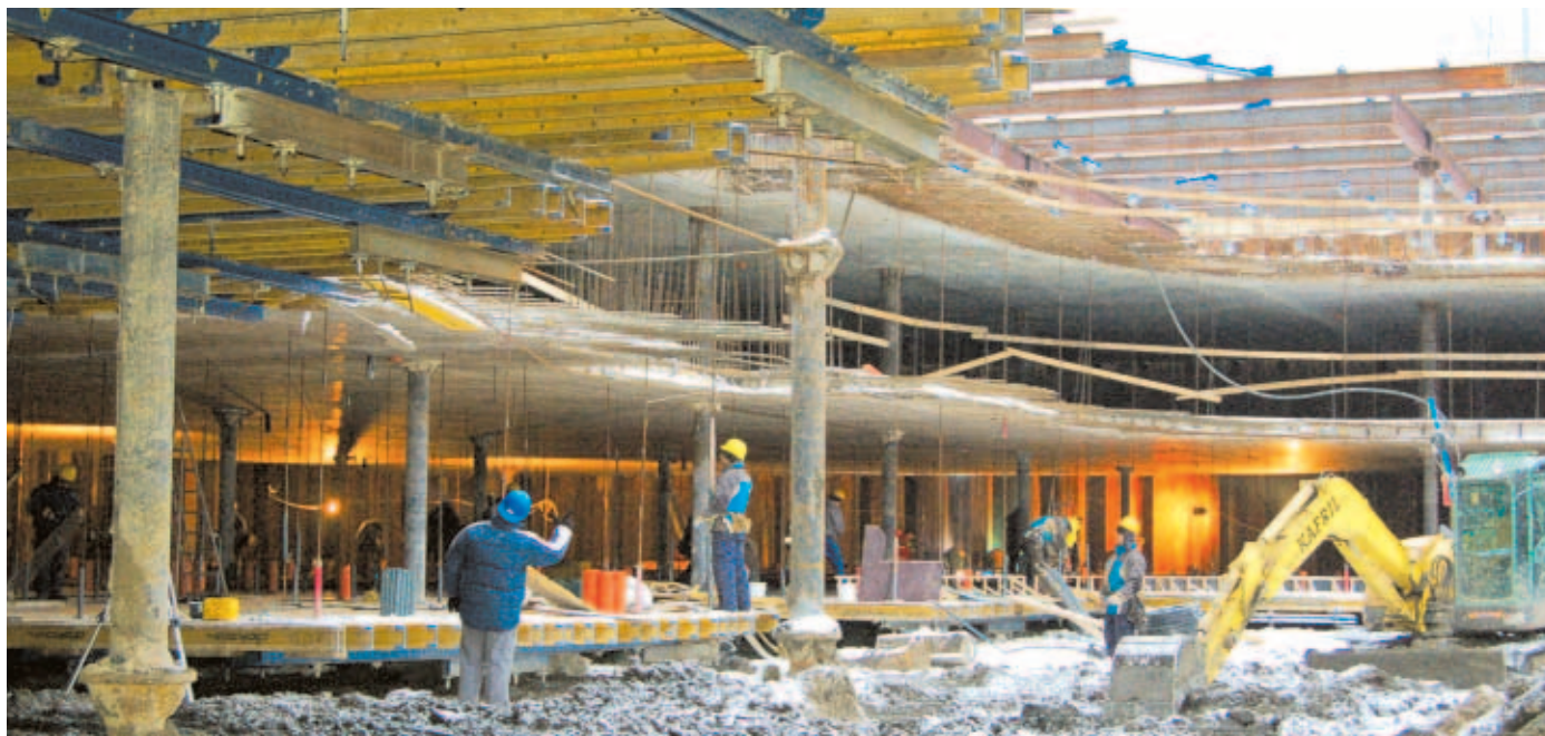
Kafril schafft Freiraum: Die Parkdecks für die künftig höchsten Gebäude Rigas wachsen. Das Großschepaer Unternehmen Kafril Service bekam den Zuschlag für die Erdarbeiten dieser Baustelle in Lettland.
