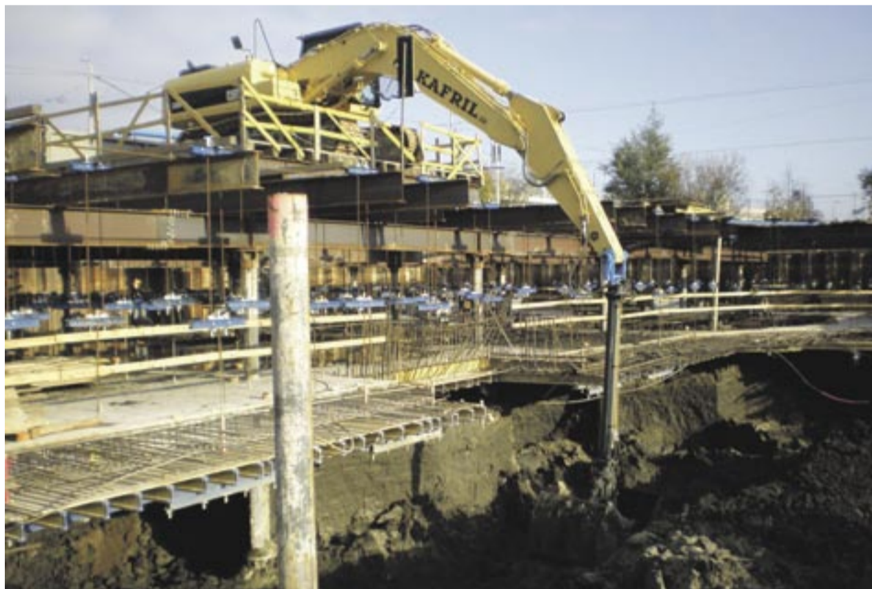
In Riga entstehen die so genannten Z-Towers, bestehend aus zwei verbundenen Türmen, die 30 Stockwerke hoch werden sollen. Darunter wird eine vierstöckige Tiefgarage gebaut.
