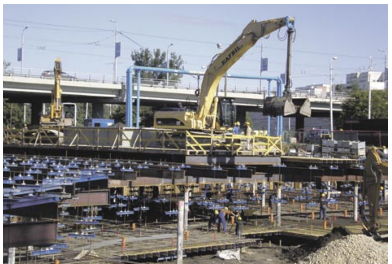
Im Einsatz ist unter anderem eine Laderaupen Cat 953 C, deren Laufstränge eigens für diese Baumaßnahme verlängert und verbreitert wurden.
