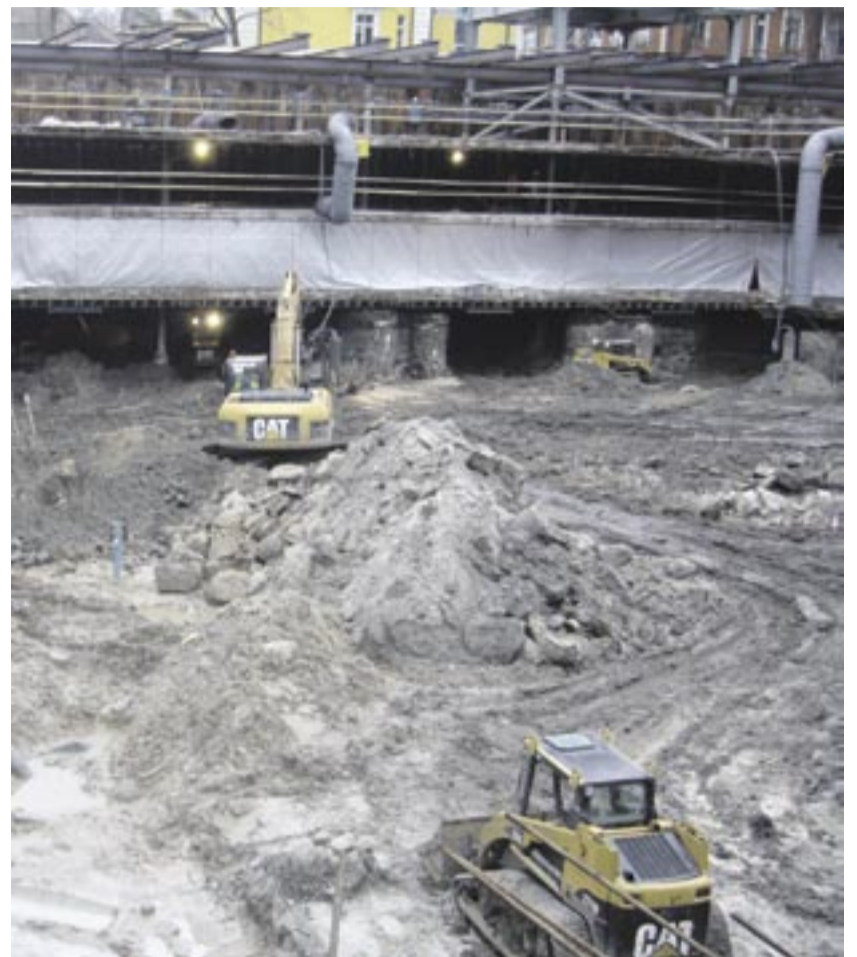
Das Unternehmen Kafril ist damit beauftragt, ein mit Spundwänden umschlossenes Baufeld im Unterdeckel-Verfahren auszuheben.
