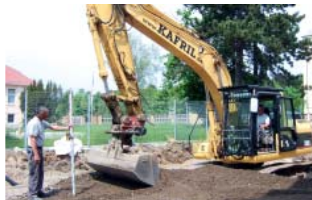
Ständige Investitionen in moderne Technik gehören bei Kafril zur Firmenstrategie. Keine der Baumaschinen – hier ein Kettenbagger CAT 318c – ist älter als zweieinhalb Jahre.
